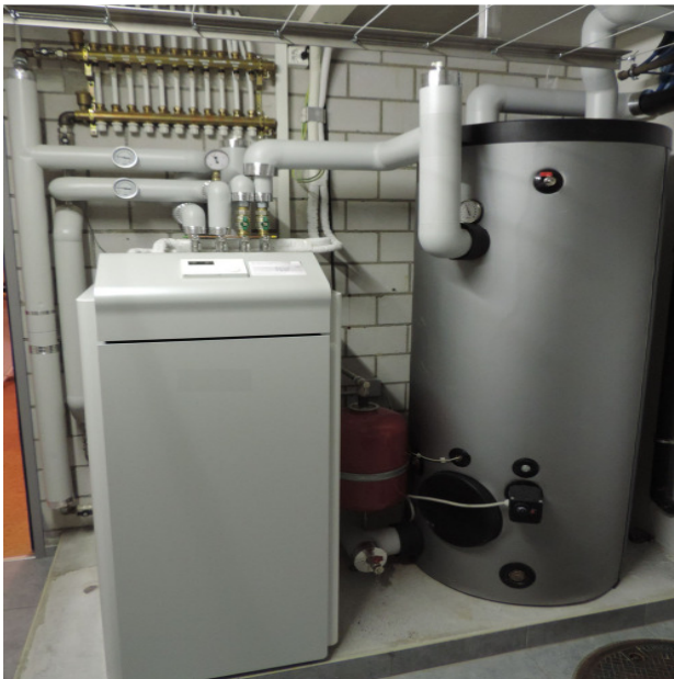
Abb. 25: Inneneinheit Inverter-Wärmepumpe
