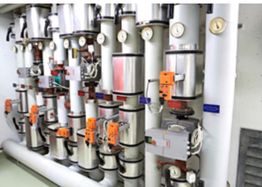
Wassererwärmer und Verteilbalken blieben bestehen und wurden hydraulisch eingebunden.
