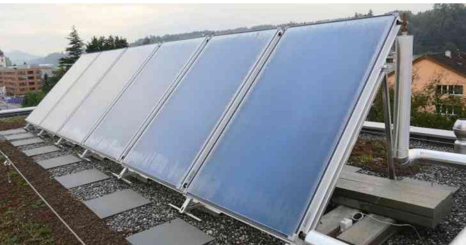
Auf dem Flachdach wurden die Kollektoren im idealen Winkel zur Sonneneinstrahlung ausgerichtet.
