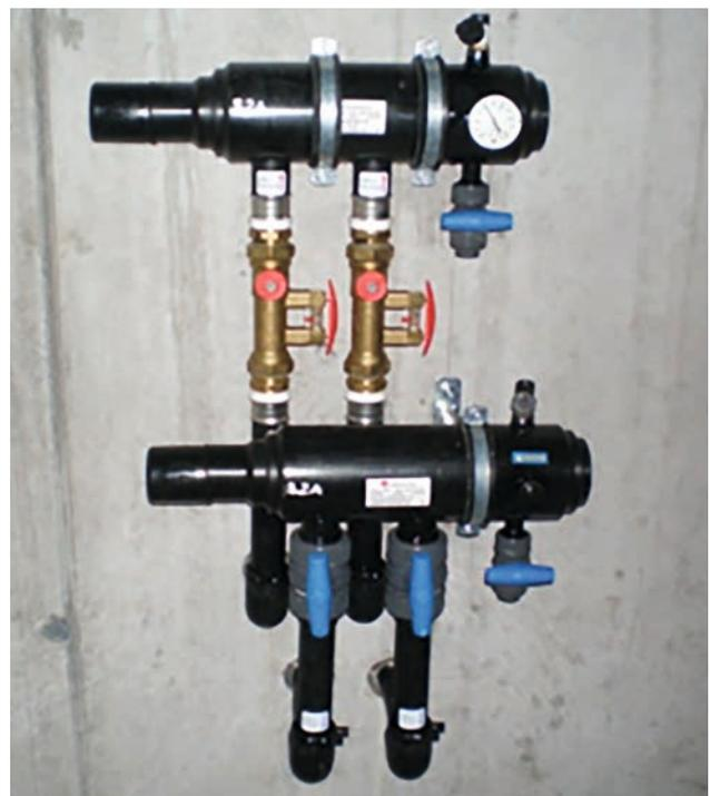
Verteiler / Sammler mit zwei Erdwärmesonden
