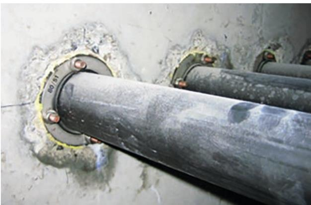
Rohrdurchführungen mit Dichtring in Aussenwand
