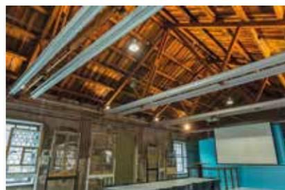
In Objekten mit ammoniakhaltiger Luft (zum Beispiel Stallungen) oder in Leichtbau-Gebäuden, die keine hohen Deckenraglast erlauben, können auch alternative Deckenstrahlprofile eingesetzt werden, bei Bedarf sogar mit Lichtbändern versehen.
