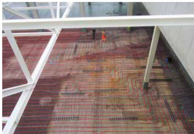
Daneben gibt es auch die Option, vorgefertigte Netze mit Heizkreis-Modulen auf der Baustelle einzubringen oder aber besonders zeiteffizient mit Betonfertigelementen zu bauen, in welche die Heizungsrohre bereits verlegt sind.
