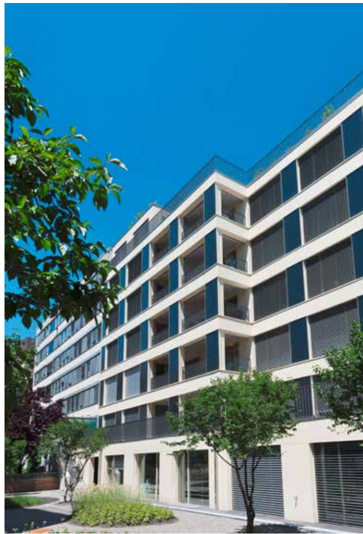
Eine Alternative zu Sonnenkollektoren auf dem Dach sind verglaste Flachkollektoren an der Fassade. © Solarpreis 2013
